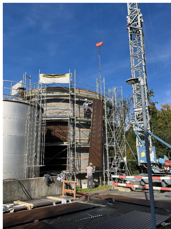
Faulturm nach dem Isolieren Einkleiden
