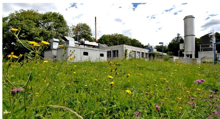
ARA Betriebsgebäude mit BHKW 1+2 und Gasfackel
