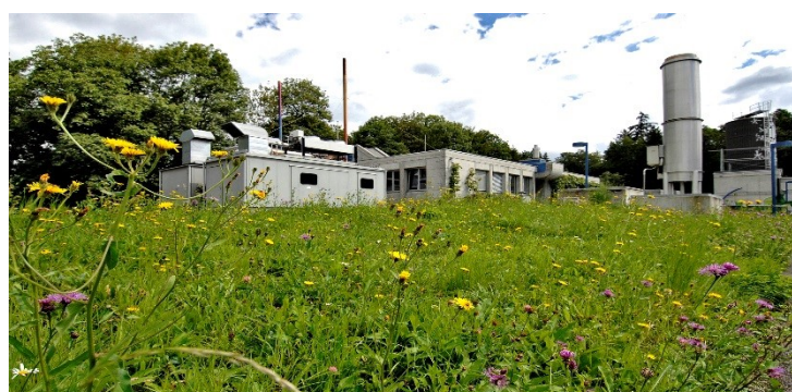
Ara Betriebsgebäude mit BHKW 1+2 und Gasfackel
